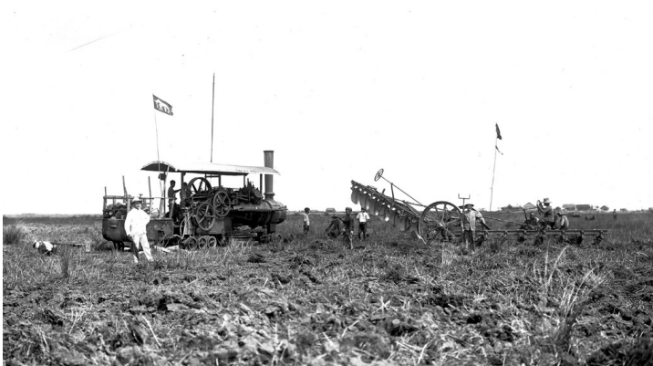
เครื่องจักรไอน้ำสำหรับไถนา ใช้งานในทุ่งรังสิต
