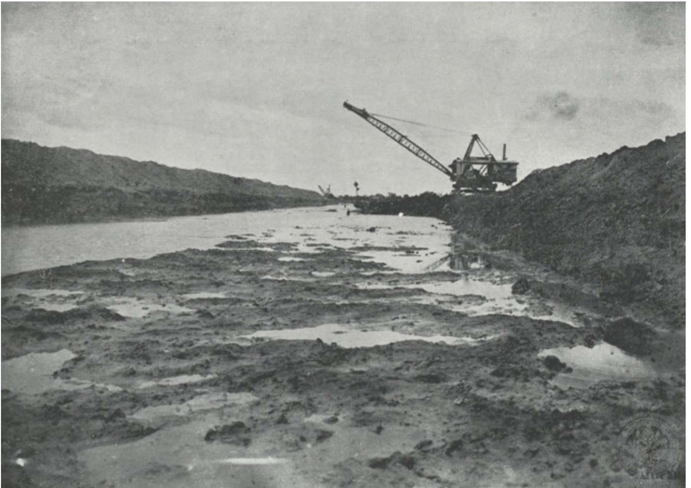
ภาพเครื่องจักรขุดคลองรังสิต นำเข้าโดยบริษัท บี. กริม
