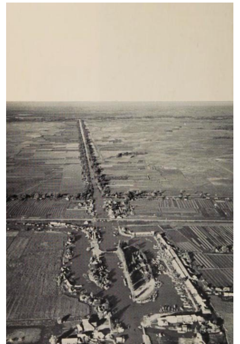
คลองรังสิตด้านทิศตะวันตก จากประตูน้ำจุฬาลงกรณ์หันไปทางแม่น้ำเจ้าพระยา
