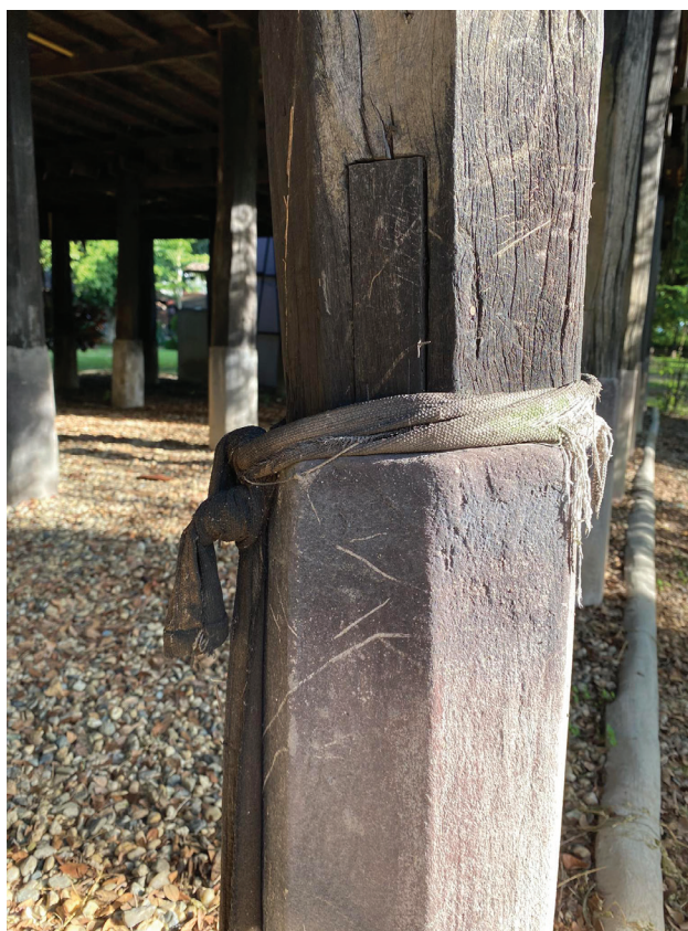
ภาพที่ 4 ผ้าที่ชุบน้ำมันขี้ไก่ มัดติดโคนเสา
