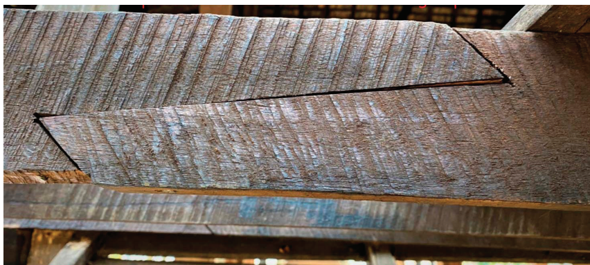
ภาพที่ 2 การต่อไม้แบบปากจระเข้
